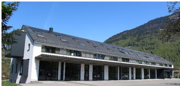
2015-2016 : Rénovations lourdes du bâtiment ; façades, fenêtres, dalles, cloisons, installations CVS-E (chauffage à gaz, ventilation, équipements sanitaires, installations électriques), toiture, couverture, isolation.
