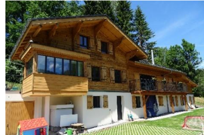
Le chalet après transformation
