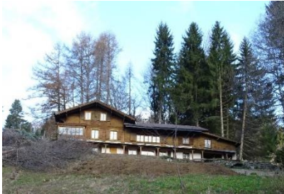
Le chalet avant transformation
